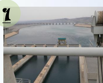
Le barrage de Birecik
